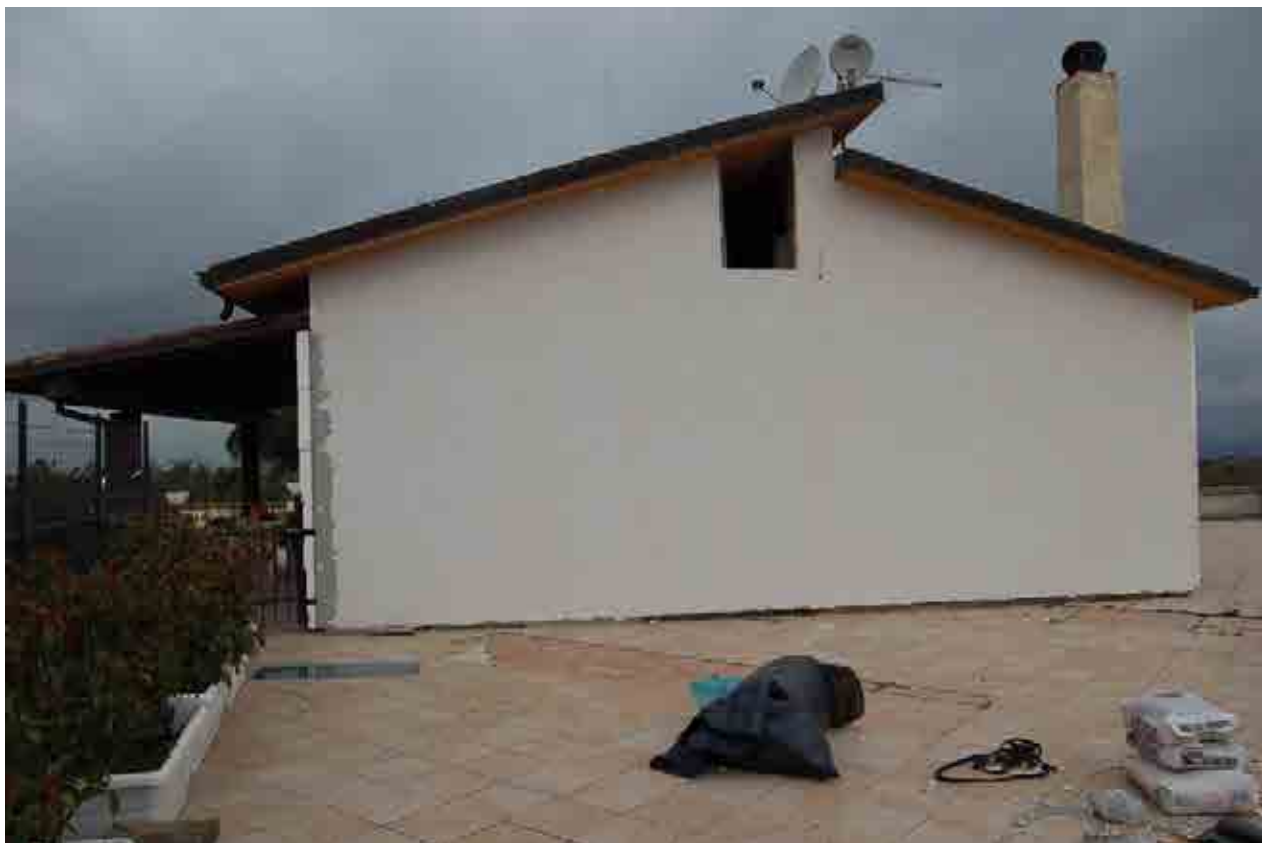
Foto 74 - Fabbricato isolato fronte est
