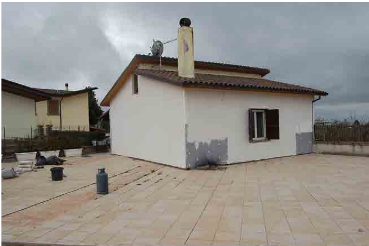
Foto 73 - Fabbricato isolato fronte nord-est
