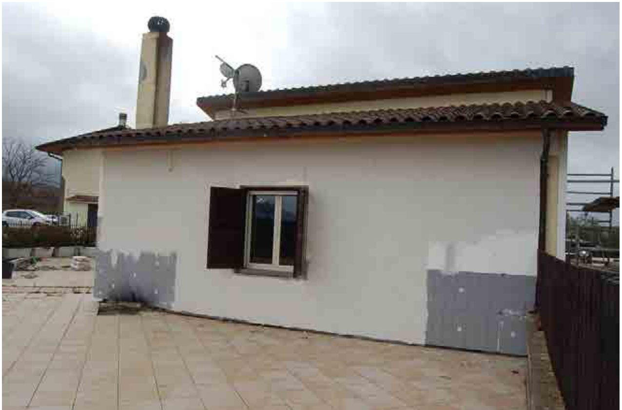
Foto 71 – Fabbricato isolato fronte nord
