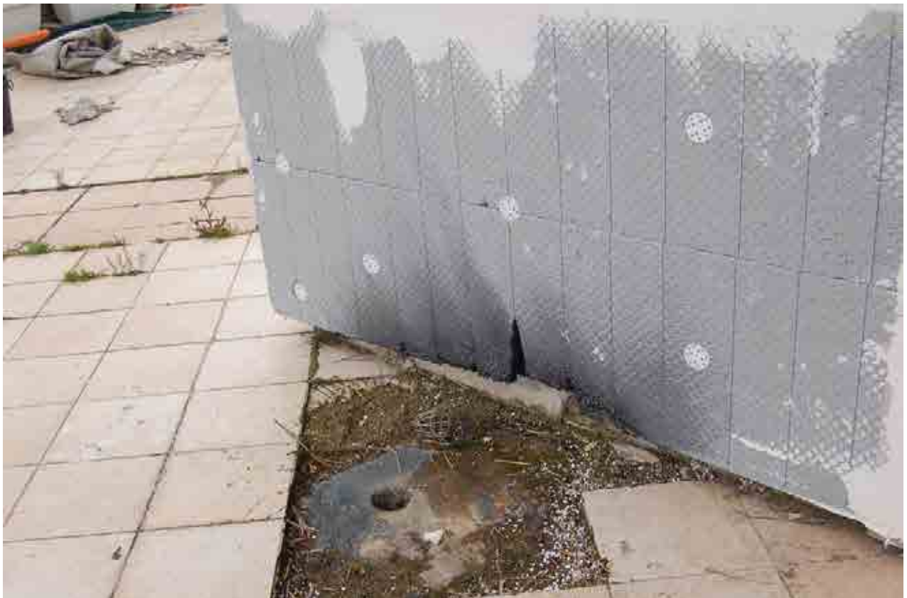
Foto 72 – Dettaglio pavimento esterno
