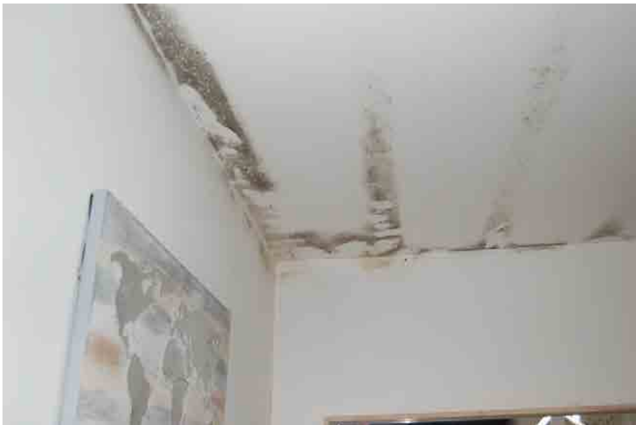
Foto 78 - Dettaglio solaio salotto
