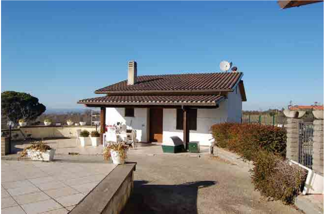
Foto 69 – Fabbricato isolato fronte sud
